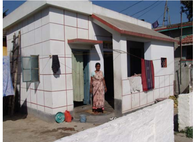
Fertiges Haus, gebaut von Ingenieurstudenten
